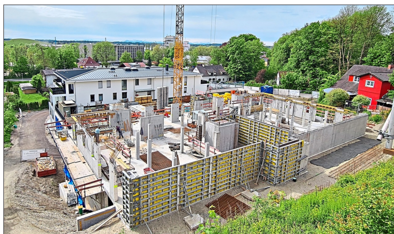
Das eine Haus (im Hintergrund) an der Innstraße 3 ist bereits fertig, an dem anderen wird gerade noch gebaut.
